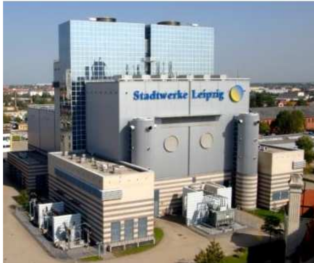
Gas- und Dampfturbinenheizkraftwerk: Heizkraftwerk Leipzig-Nord
